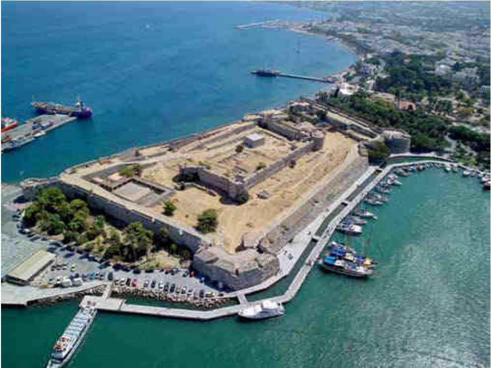
Το Κάστρο της Κω (Νεραντζιάς). Οι φυλακές βρίσκονταν στο βορειοανατολικό άκρο του.
